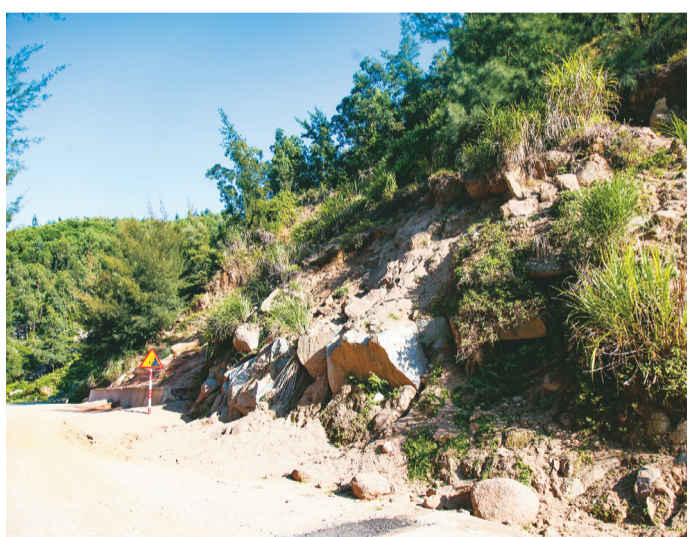
Việc khắc phục tình trạng sạt lở trên tuyến đường quốc phòng ven biển đoạn qua thôn 1, xã Cẩm Lĩnh khá phức tạp.
