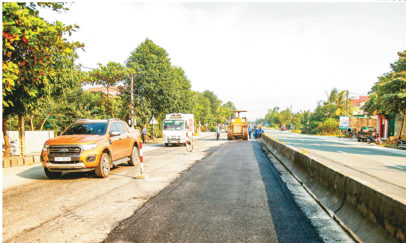
Hạt Quản lý đường bộ Chi nhánh BOT tuyến tránh thành phố Vinh (Nghệ An) đang cào bóc, thẩm lý quốc lộ 1 đoạn qua xã Việt Tiến, huyện Thạch Hà (Ảnh chụp chiều 18/10).
