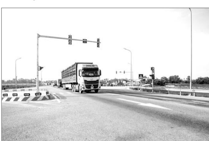
Hệ thống đèn tín hiệu giao thông được lắp đặt góp phần giảm thiểu tai nạn giao thông tại nút giao.
